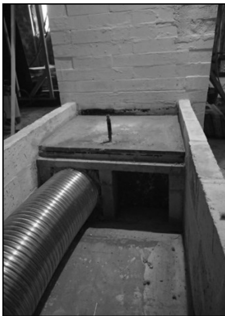
Un clapet bi-directionnel oriente les gaz dans la gaine ou dans le conduit maçonné.
