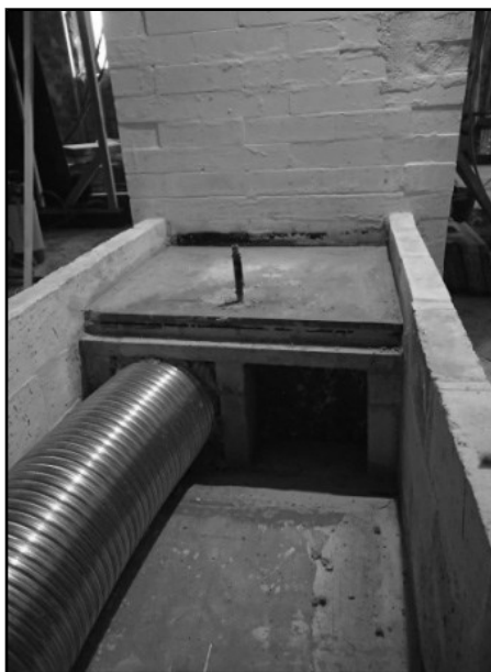
Un clapet bi-directionnel oriente les gaz dans la gaine ou dans le conduit maçonné
